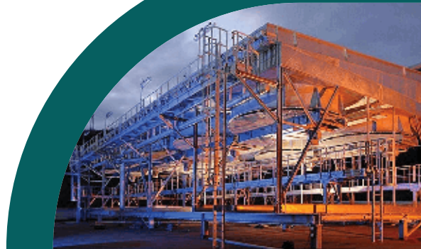
Fin Fan Repair
